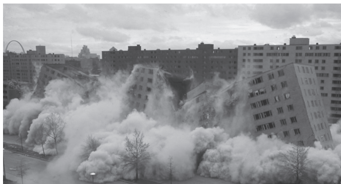
Снос жилого комплекса Pruitt-Иггоу, Сент-Луис
